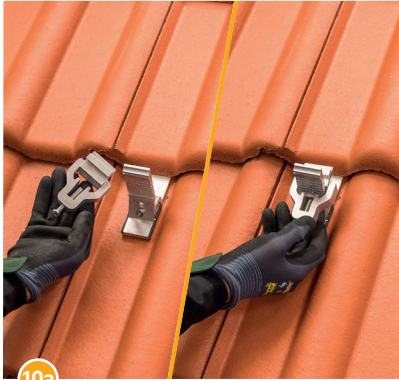
10a Die horizontale Klemmkombination auf die Stütze stecken.
