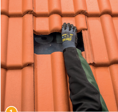
1 Den Dachziegel hochschieben.
