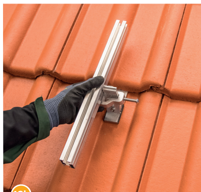
12b Die RAIL ausrichten und einhängen.
