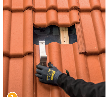
3 ...und Dachziegel einhängen.
