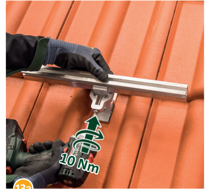
13a Die Klemmkombination mittels Schraube (10 Nm ± 0,5 Nm) festziehen - fertig!
