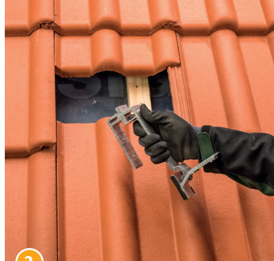
2 Den Haken unterhalb von Dachlatte...
