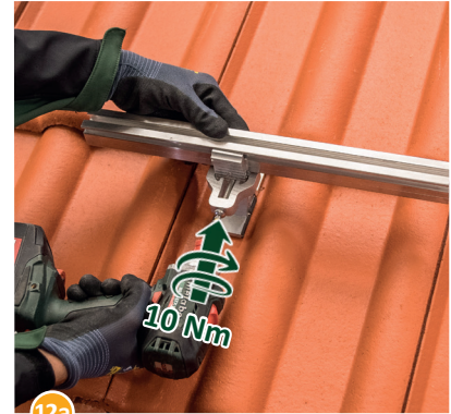
12a Die Klemmkombination mittels Schraube (10 Nm \pm 0,5 Nm) festziehen - fertig!
