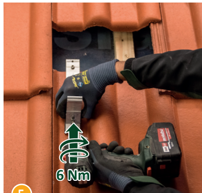
5 Die Stütze ( 6 \text{ Nm} \pm 0,5 \text{ Nm} ) fest verschrauben.
