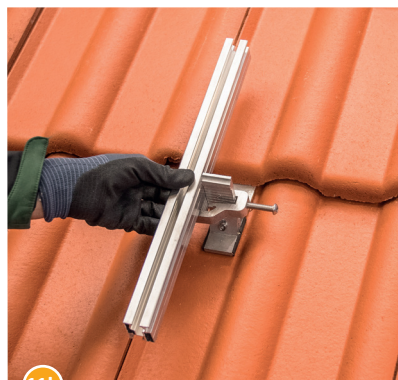
11b Die RAIL ausrichten und einhängen.
