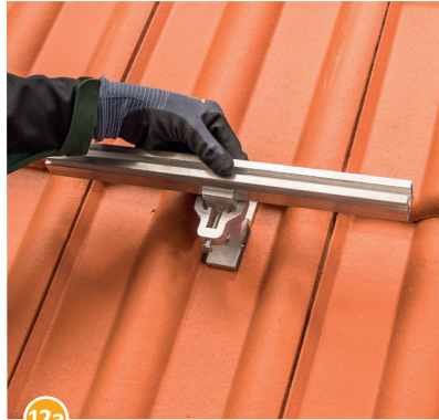
12a Die RAIL ausrichten und einhängen.
