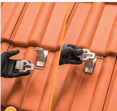
11b Die vertikale Klemmkombination auf die Stütze stecken.
