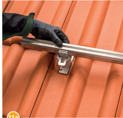
11a Die RAIL ausrichten und einhängen.
